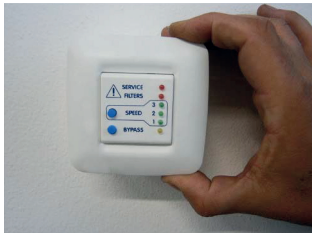
12. Ovládací panel upevněte na požadované místo
