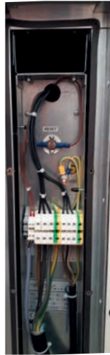
přístup k přípojovací svorkovnici ohřívače – – po sejmutí čelního panelu na obslužné straně jednotky
